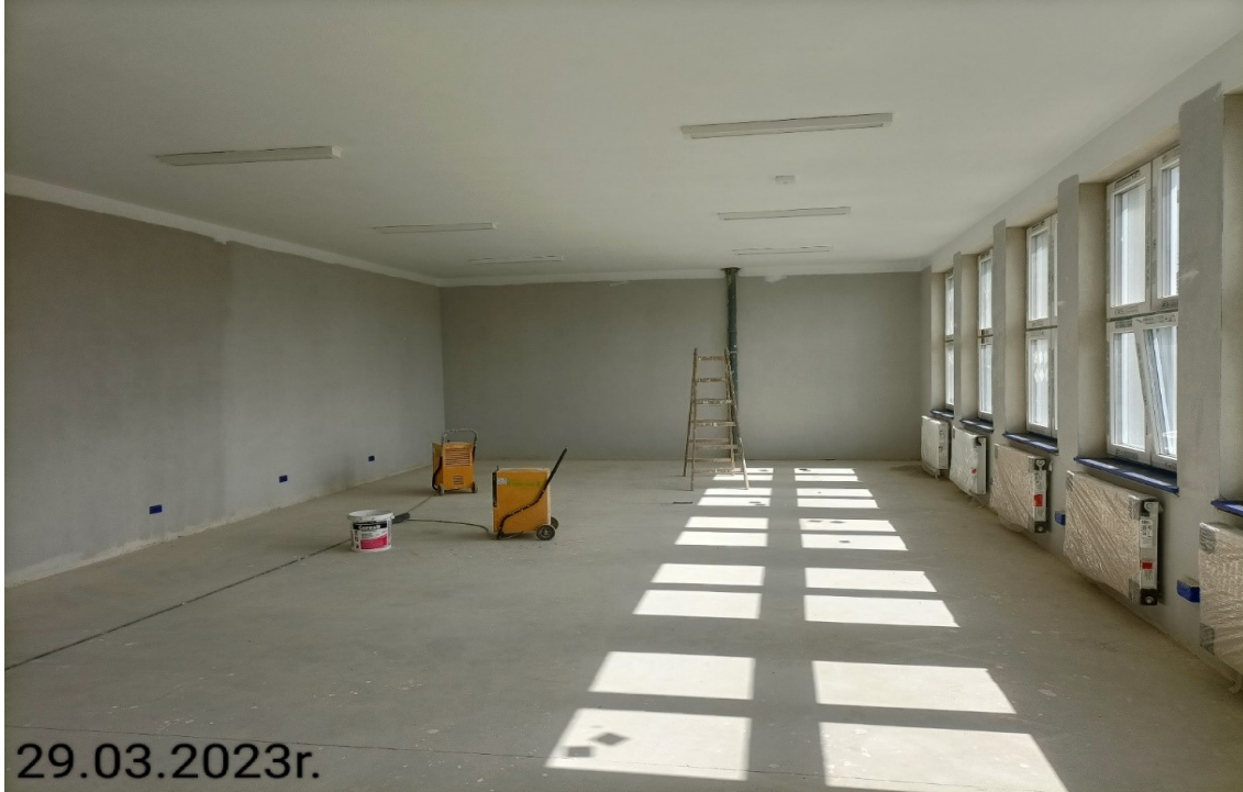
Zdjęcie 1. Widok na tylną ścianę sali – data wykonania zdjęcia 29.03.2023r.
